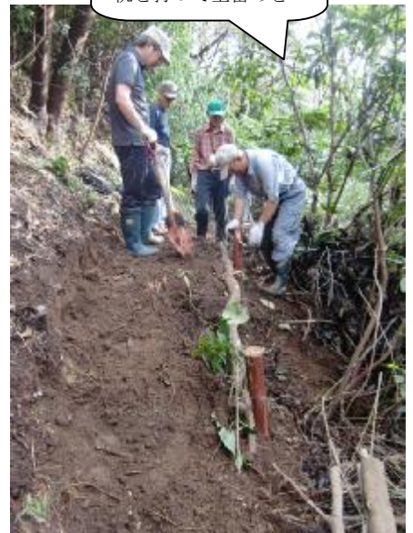
斜面は平らに均そう。 杭を打って土留めを
