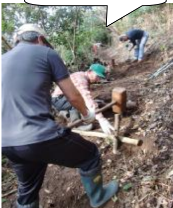
この斜面にも階段を2段
